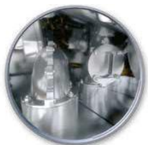
EINGEBAUTE ABGAS-RÜCKSCHLAGVENTILE
