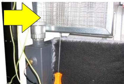
Die Ventilator-Leistungen überprüfen und die gesamte Abgasführung bis zum Austritt auf einwandfreie Funktion kontrollieren.
